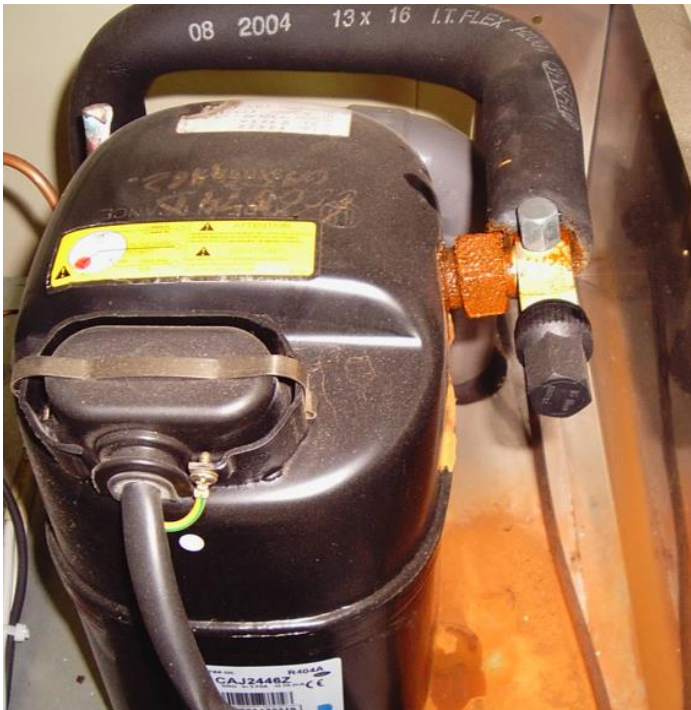
Hrdza a meď v ocelových častiach kompresora znamená vysokú vlhkosť v obvode.
